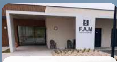
Nouveau foyer d'accueil médicalisé à Bolbec
